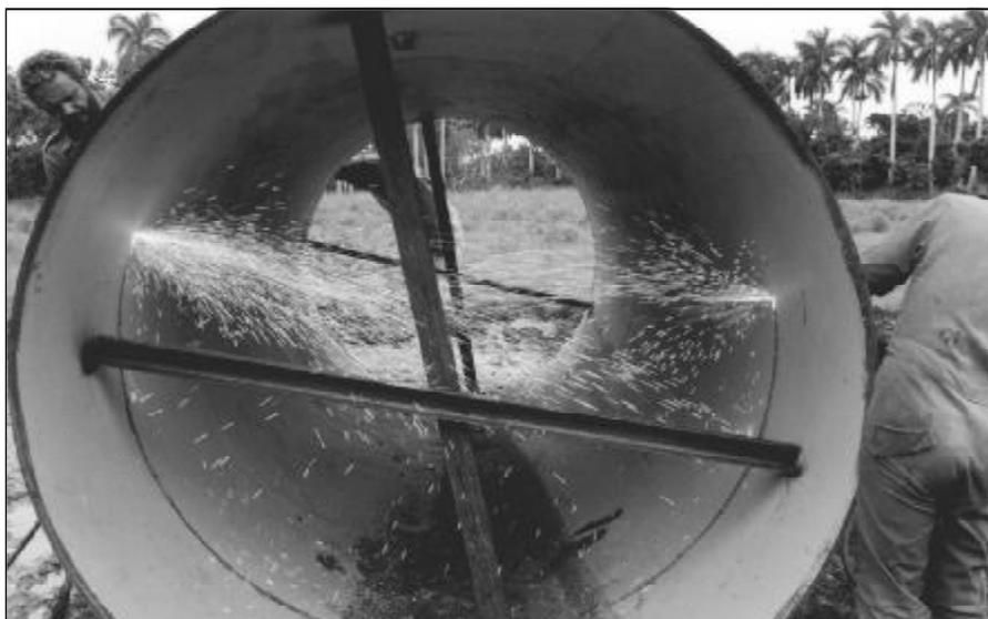
Obras preparatorias para sustituir un tramo de la Conductora de Cuenca Sur.
