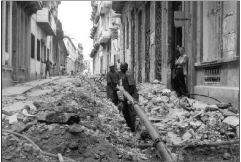
*Tuberías de PE de alta densidad sustituyen a los viejos tubos galvanizados.*
