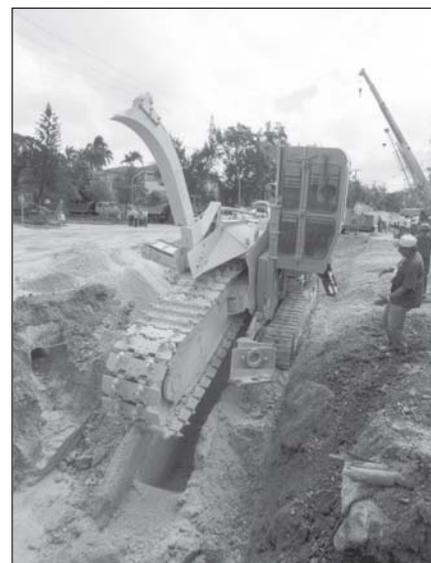
*Dos de las zanjadoras utilizadas en los trabajos de rehabilitación de redes.*
