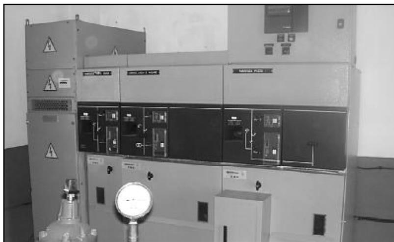
*Pizarra de mando de una moderna estación de bombeo que controla de forma automática el arranque y parada de los equipos de bombeo.*
