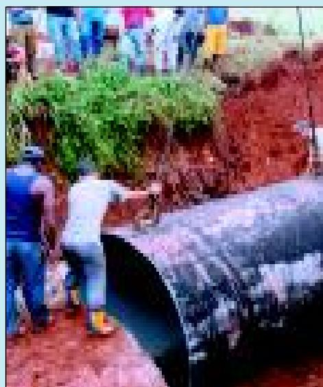
*La acción de rehabilitar es múltiple y sistemática. Sólo de este modo la gestión alcanza eficiencia, y se mejora el servicio. En la foto vemos la sustitución de un tramo de tubería de setenta y ocho pulgadas de diámetro perteneciente a la conductora Cuenca Sur.*
