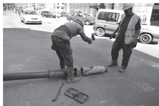
Desmontaje del Topo
